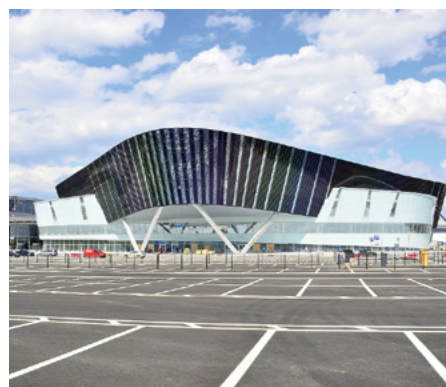
Конгресс-Холл, Екатеринбург-ЭКСПО, г. Екатеринбург
