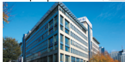
R&D центр Fujitsu General (EURO) GmbH (Германия)
