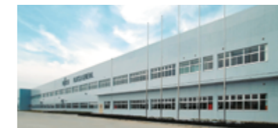
Fujitsu General Central Air-conditioner (Уси) Co., Ltd. (Китай)
