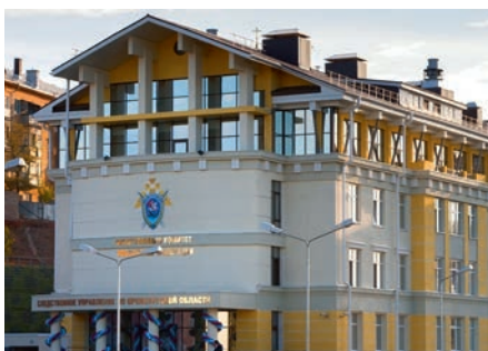
Следственный комитет, г. Оренбург Мультизональные системы MVS DANTEX
