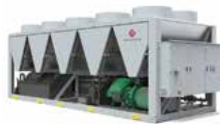
Винтовые компрессоры, R134a DN-P168-1770VYSONH 168-1770 кВт
